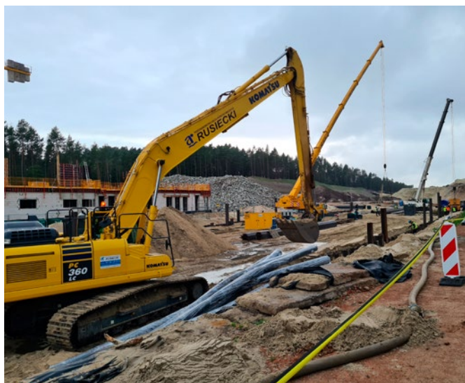
Fot. 19. Realizacja robót ziemnych
