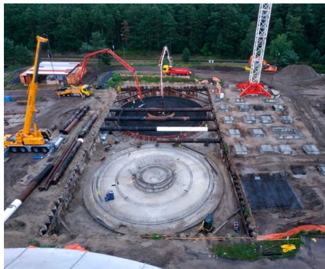
Fot. 13. Widok na fundament komory fermentacyjnej
