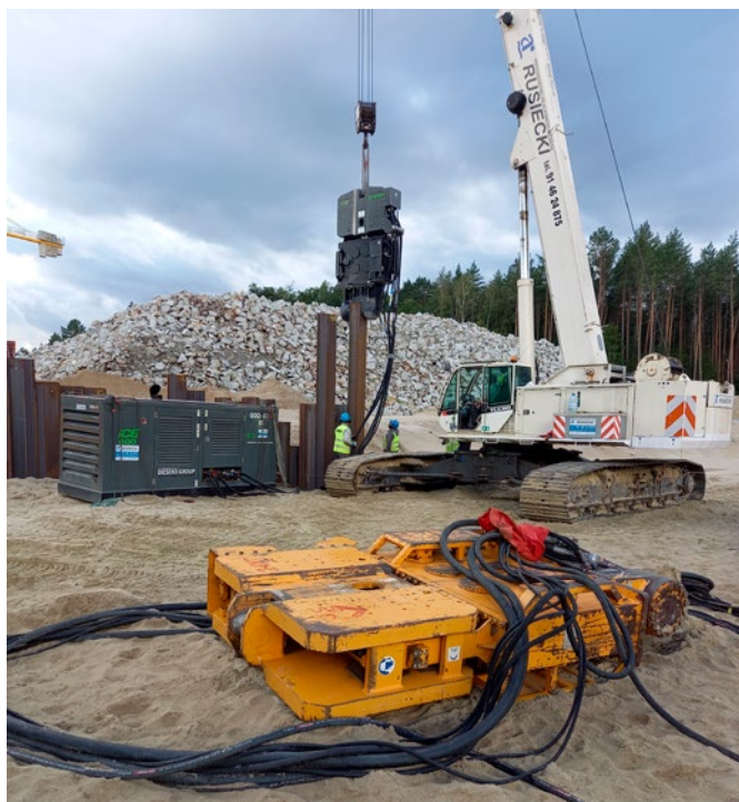
Fot. 17. Realizacja robót kafarowych
