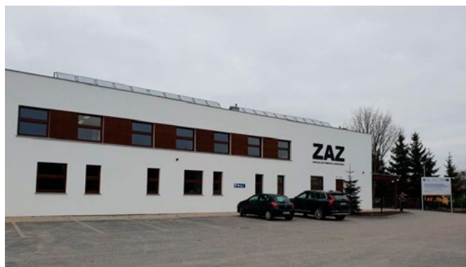
Fot. 3. Budynek po zakończeniu robót budowlanych
