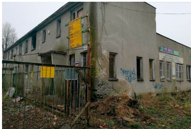
Fot. 1. Stan budynków przed rozpoczęciem robót
