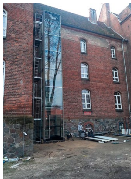
Fot. 6. Budynek przy ul. Bydgoskiej 50 w Wałcu w trakcie przebudowy
