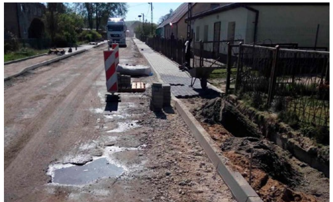
Fot. 16. Modernizacja drogi powiatowej w terenach zabudowanych
