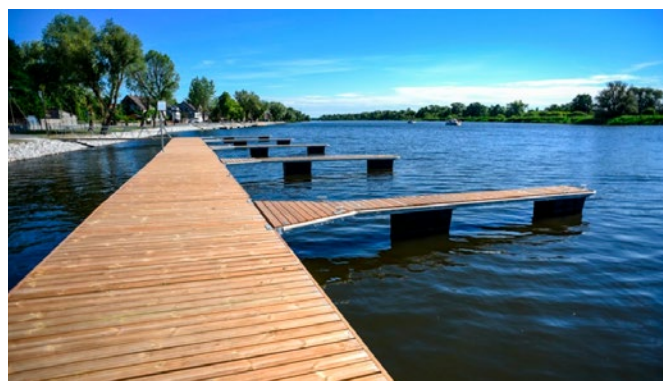
Fot. 3. Widok na pomost (źródło: Radio Szczecin)
