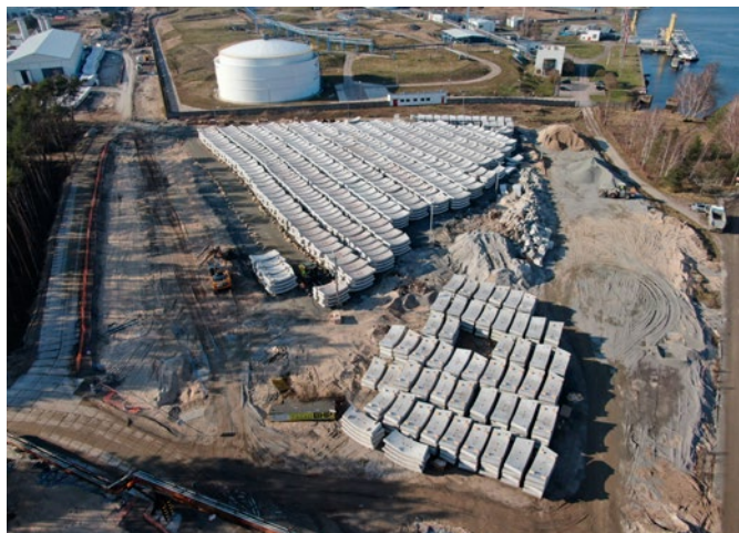
Fot. 1. Jeden z placów, na których składowane są elementy pierścieni tzw. tubingi. Każdy element ma swój numer
