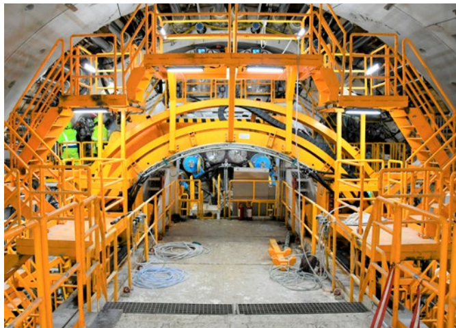
Fot. 4. Czoło maszyny TBM w tunelu
