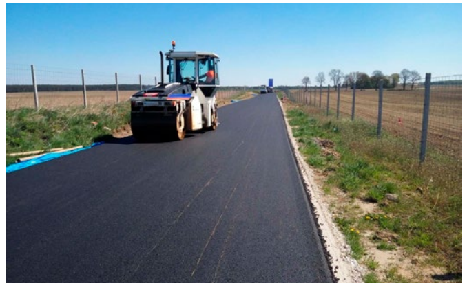
Fot. 15. Przebudowa drogi powiatowej
