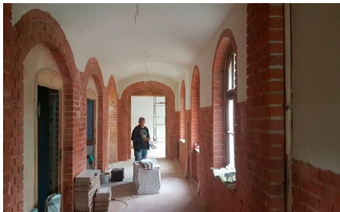
Fot. 7. Roboty adaptacyjne w budynku
