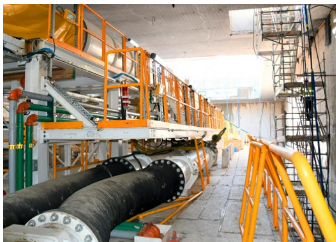
Fot. 5. Wnętrze maszyny TBM, na pierwszym planie rury odprowadzające urobek z drążenia tunelu
