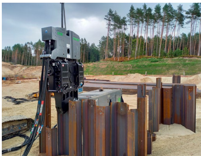
Fot. 18. Realizacja robót kafarowych
