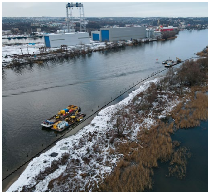
Fot. 21. Wykonanie konstrukcji nabrzeża wyspy Radolin
