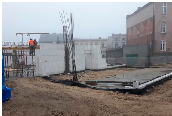
Fot. 11. Roboty fundamentowe i pierwsze ściany parteru budynku
