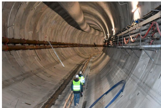
Fot. 3. Wewnątrz wydrążonego tunelu
