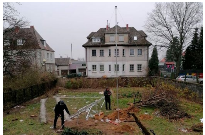
Fot. 21, 22. Montaż elementów energetyki odnawialnej
