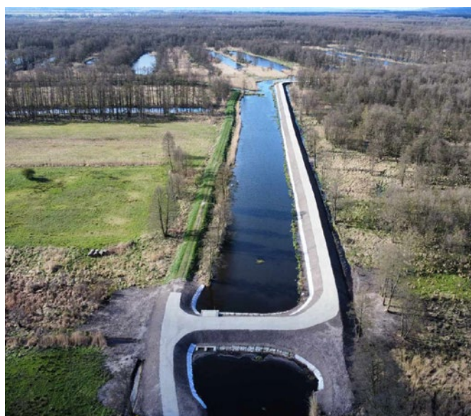
Fot. 24. Wał czołowy z przepustem wałowym i wjazdem na wał
