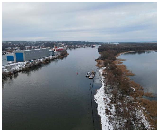
Fot. 20. Wykonanie konstrukcji nabrzeża wyspy Radolin
