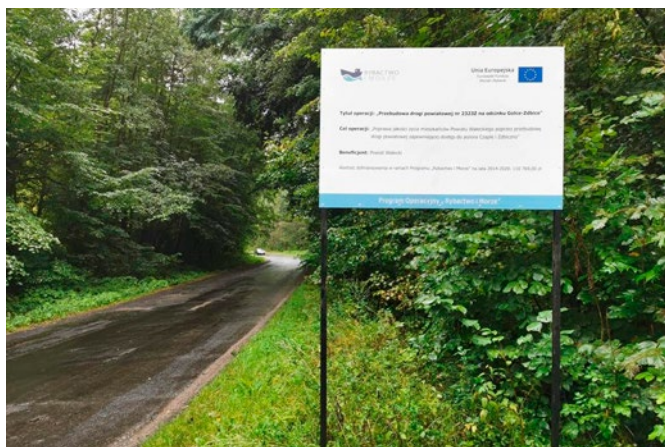
Fot. 20. Stan jezdni po przebudowie
