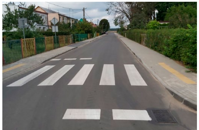
Fot. 17. Zrealizowany odcinek drogi powiatowej w obszarze zabudowanym
