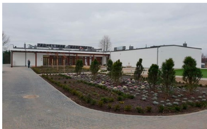
Fot. 4. Zagospodarowanie terenu zakładu
