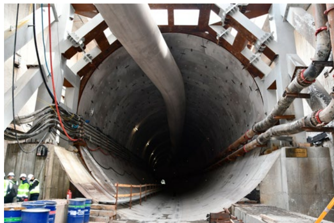
Fot. 2. Wlot do tunelu drążonego przez TBM WYSPIARKA
