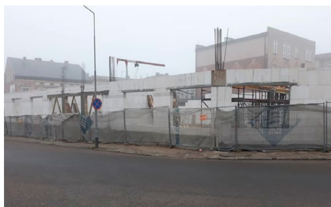
Fot. 12. Widok ścian parteru od strony ul. Szkolnej w Wałczu
