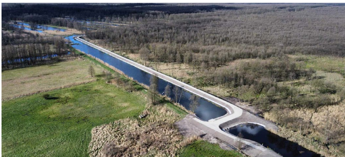
Fot. 22. Wał nad Kanałem Królewskim wraz z wałem czołowym
