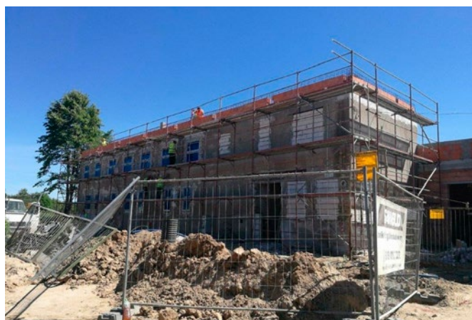
Fot. 2. Budynek główny Zakładu Aktywności Zawodowej podczas przebudowy
